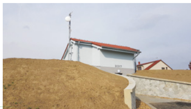
Rozšíření vodojemu Zbýšov, dotace: 6 677 900 Kč
