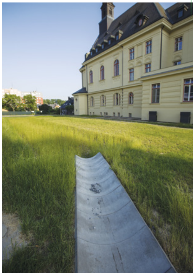
Vybudování zasakovacího průlehu s rýhou u parkoviště v Bruntále, dotace: 1 253 742 Kč
