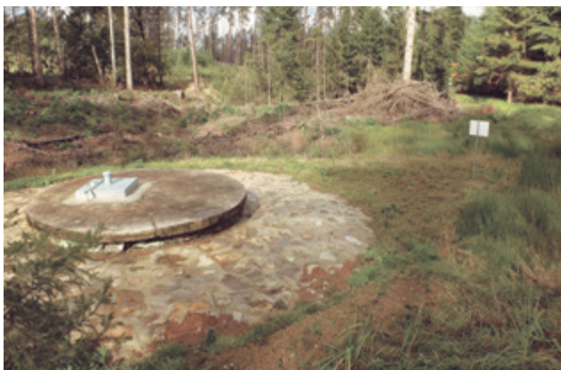
Vystrojení hydrogeologického vrtu a jeho napojení na vodovodní systém obce Hříšice, dotace: 2 191 174 Kč
