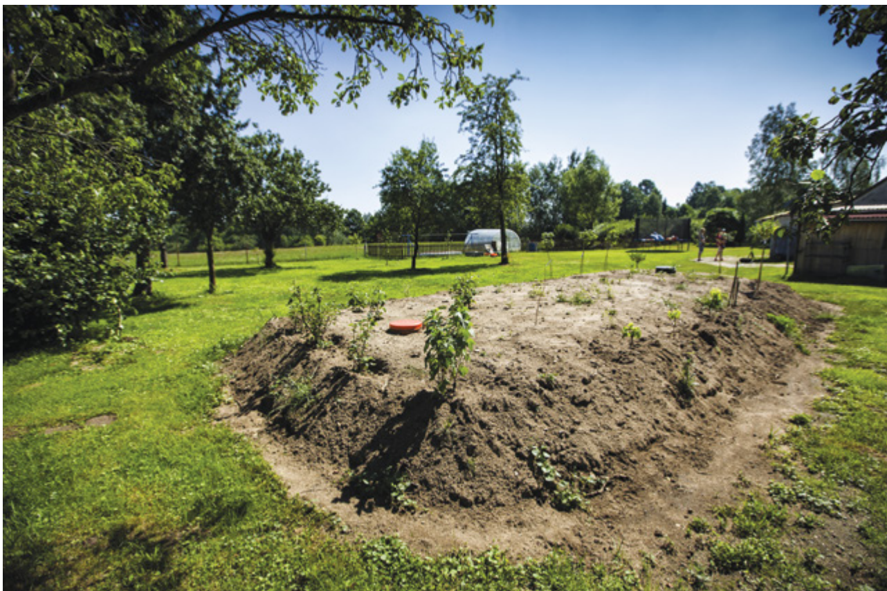
Čištění odpadních vod v obci Dvory nad Lužnicí, dotace: 1 270 000 Kč
