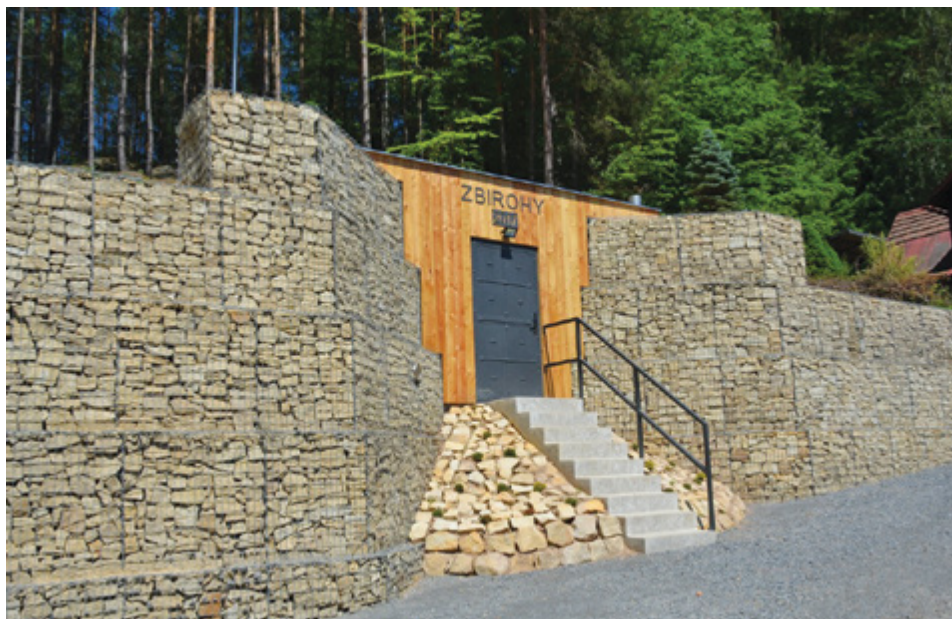
Obec Rakousy – Rozšíření akumulace vodního zdroje (vodojem Zbirohy), dotace: 1 851 048 Kč
