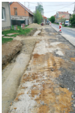
Čejkovice – splašková kanalizace a ČOV, dotace: 14 295 721 Kč
