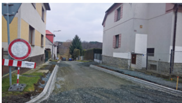
Prodloužení vodovodu v Blovicích, lokalita Hájek, dotace: 2 672 363 Kč
