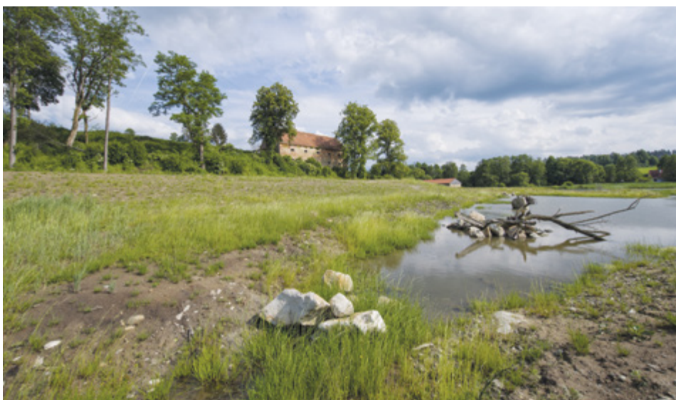
Výstavba tůní a oprava Náglovy stezky u obce Kostelní Myslová, dotace: 5 192 180 Kč
