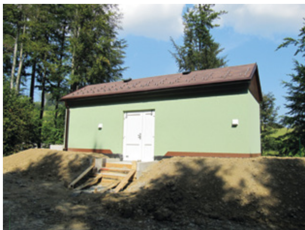
Rozšíření vodovodu Hošťálková pomocí dvou nových vrtaných studní, vybudováním přivaděčného řadu a nového vodojemu, dotace: 3 924 864 Kč
