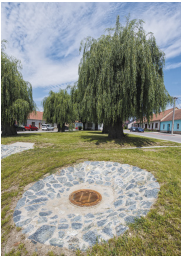
Přísnovice – Lokalita Za Kostelem, Hospodaření se srážkovými vodami, dotace: 5 688 420 Kč
