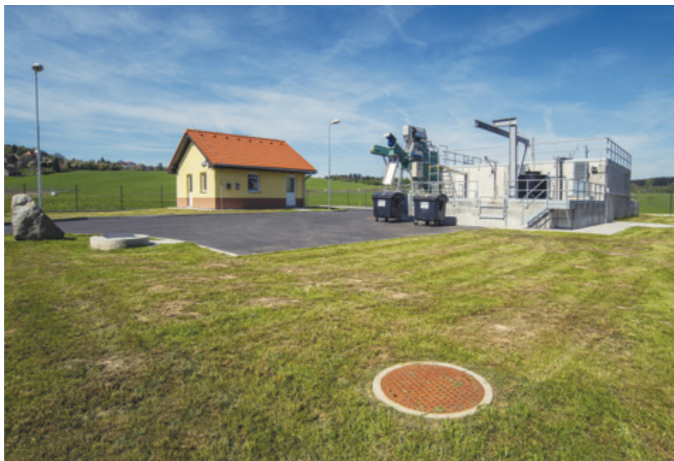
Výstavba kanalizace a nové ČOV v Plánici, dotace: 25 907 394 Kč
