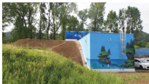
Čebín Podhájí – modernizace úpravy vody a zvýšení kvality zdroje pitné vody, dotace: 15 124 270 Kč
