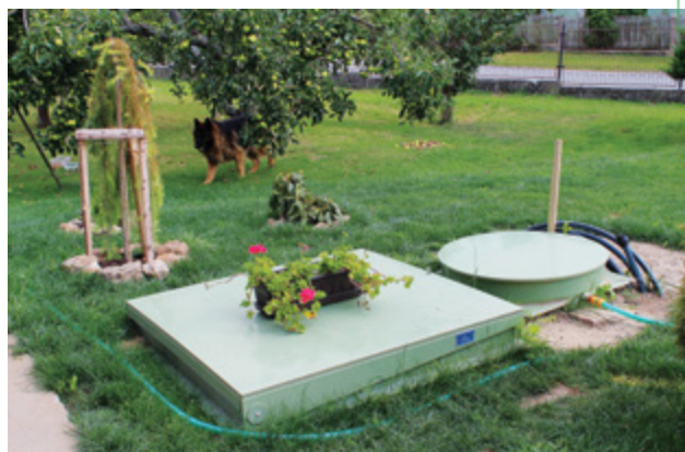
Odkanalizování obce Vodranty prostřednictvím soustav DČOV, dotace: 2 503 645 Kč
