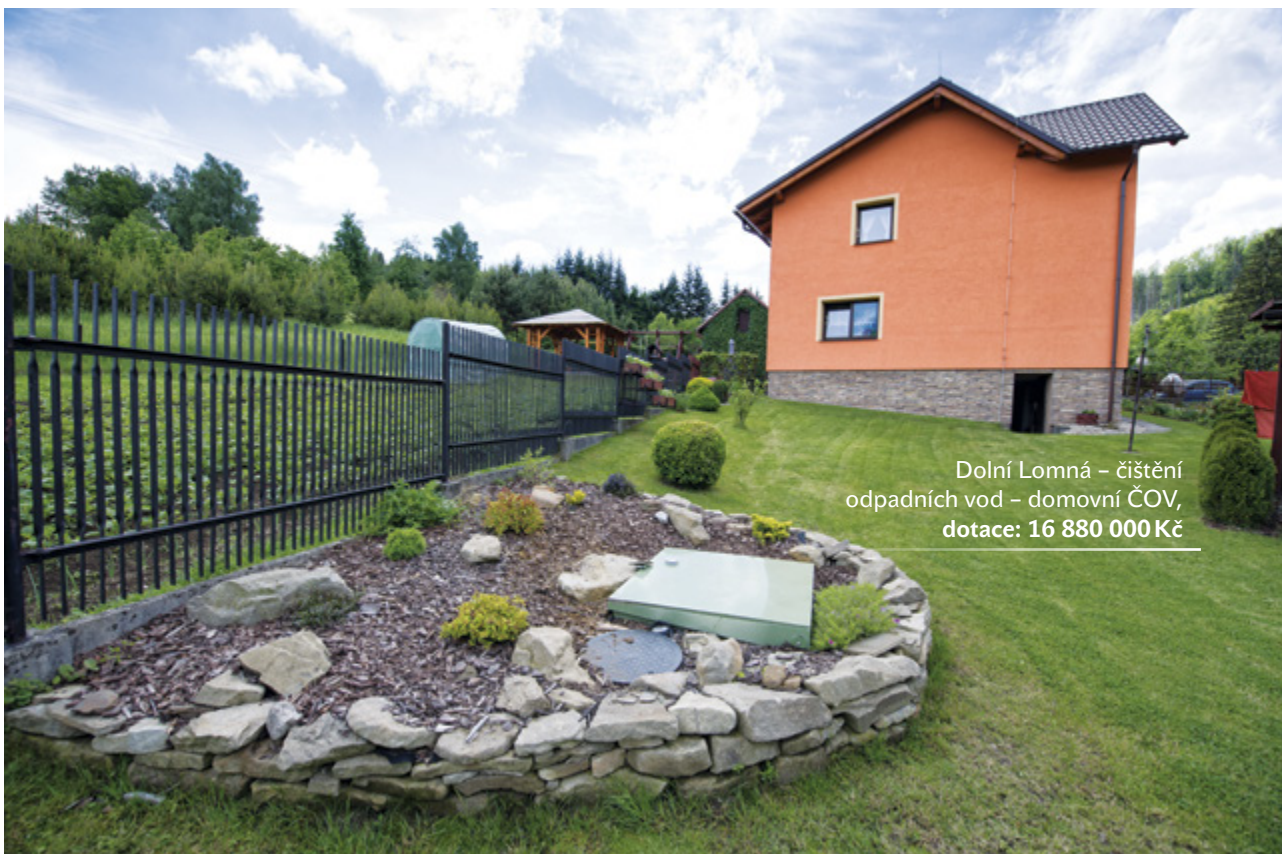
Odkanalizování obce Starkoč pro- střednictvím soustav DČOV, dotace: 4 380 000 a 2 040 000 Kč
