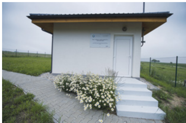
Vrchy – revitalizace vodního zdroje HV-1 a úprava pitné vody, dotace: 3 000 000 Kč
